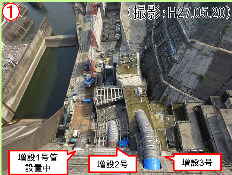
増設1号放流管引き込み中・・・
