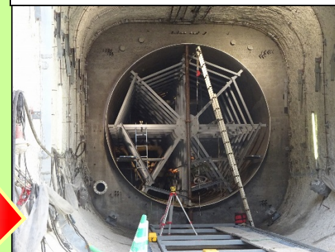
コンクリート充填完了
