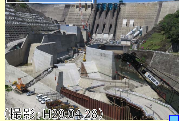
ダム下流から撮影
