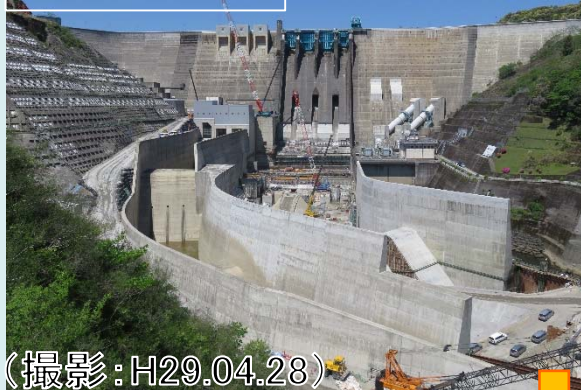
ダム下流から撮影
