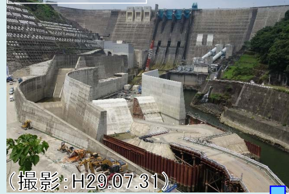
ダム下流から撮影
