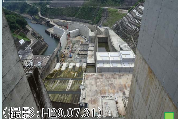
ダム天端から撮影
