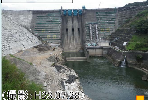
ダム下流から撮影
