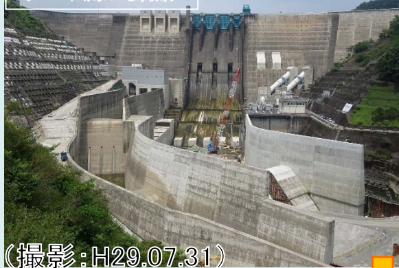
ダム下流から撮影
