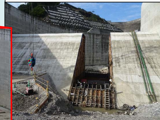
コンクリート打設の様子
