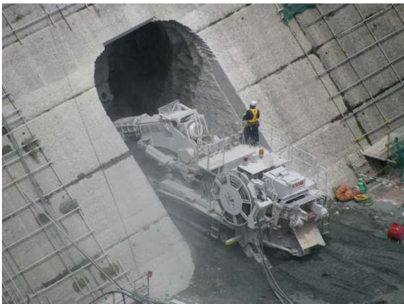
■ 堤体削孔状況
