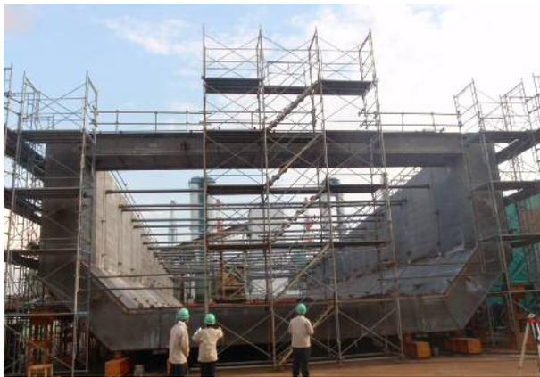
ダム上流の「囲み」は鋼製です。工場で製作します。
