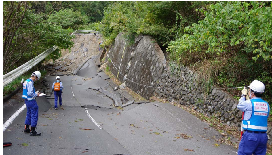
おかのまち △小鹿野町道704号線 埼玉県小鹿野町
