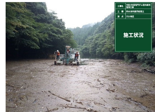
貯水池内の流木処理状況 (令和3年9月)
