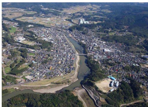
推込分水路付近の川内川 (さつま町虎居周辺)
