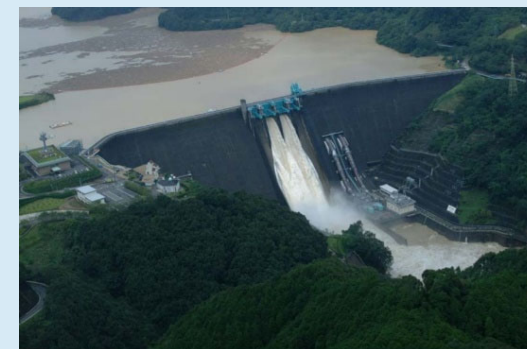
平成18年7月洪水時の鶴田ダム放流状況
