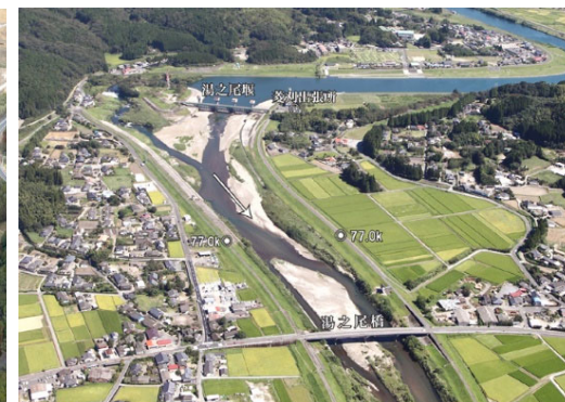
湯之尾堰付近の川内川 (伊佐市菱刈地内)
