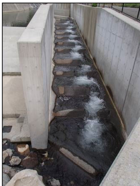
魚道の状況(R4.5月) ※魚道内に土砂の堆積なく通水
