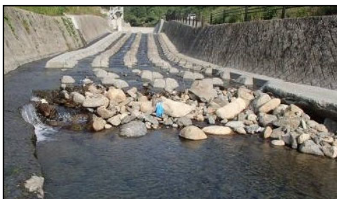
取水堰下流水路の状況(R4.5月) ※令和2年7月豪雨後に自然石が流出、洗掘により根固ブロックと落差が生じていたが、土石投入により緩和
