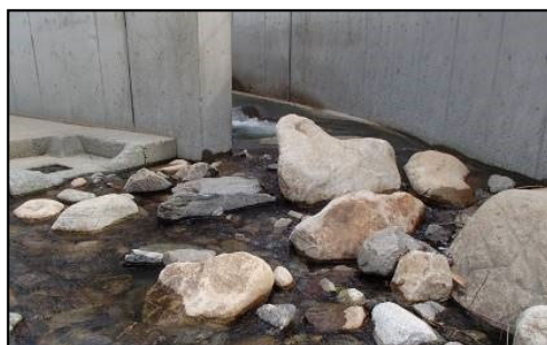
魚道入口の状況(R4.5月) ※令和3年8月の大雨後に魚道と下流水路に落差が生じていたが、土石投入により解消
