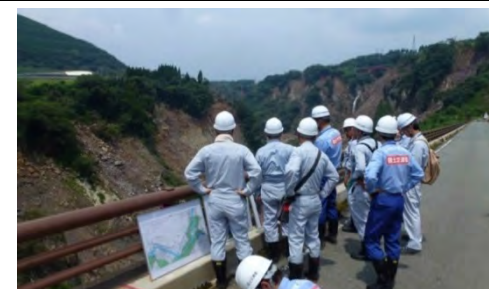
現地調査状況 (H28. 8. 3)
