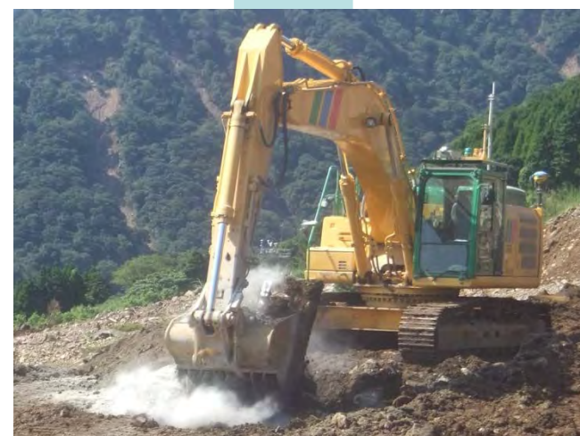
重機足場を地盤改良しながら施工
