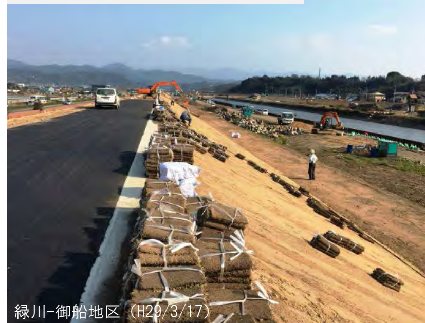
変状が発生した堤防の再構築を実施中 (張芝)
