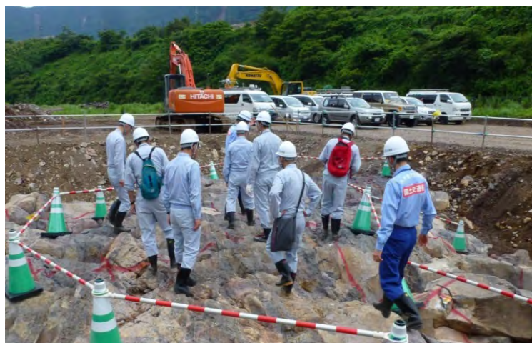
トレンチ調査の状況(H28.8.3)
