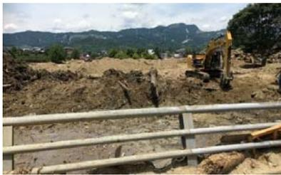
土砂により埋塞した河道の復旧工事
