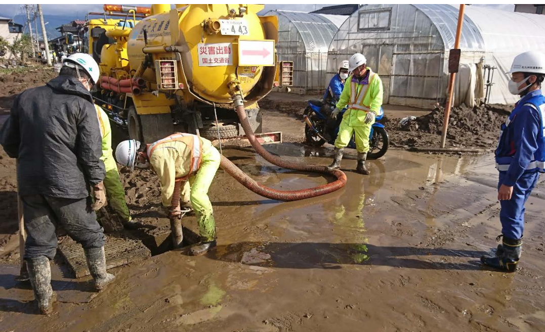
堆積土砂の撤去作業にあたる協力企業 (長野県長野市)
