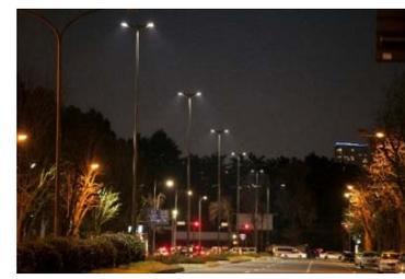
省エネルギー・低コストを目的に、高効率なLED照明を道路照明に採用するとともに、照明ポールを直線形状とし基礎を小型化するなど、1灯当たりの整備コストの縮減に配慮しています。また、安全も配慮しつつ設置間隔を見直し、全体の数量を少なくして、コストの更なる圧縮に努めています。
