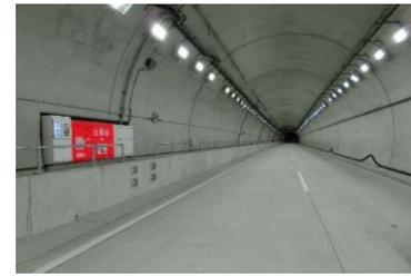
長いトンネルでは、トンネルの入口部と出口部を明るくすることで、日中、屋外とトンネル間の明暗の差を減らし、ドライバーの良好な視界を確保しています。また、LED照明の採用により、コストの縮減に配慮しています。
