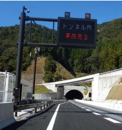
トンネル内で起きた火災や事故などが発生した場合、トンネル入口に設置された表示板で通行車に周知しています。
