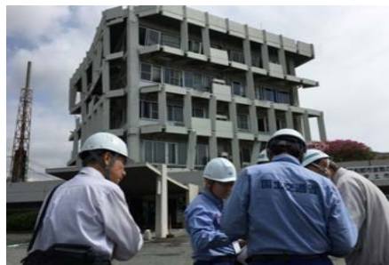
宇土市庁舎の現地調査
