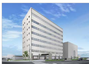
鹿児島営繕事務所
