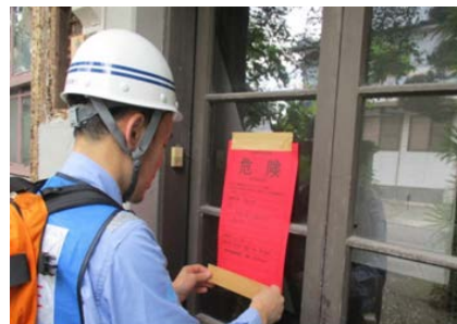
応急危険度判定の状況
