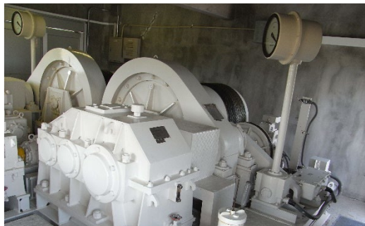
ワイヤーロープウィンチ式開閉装置
