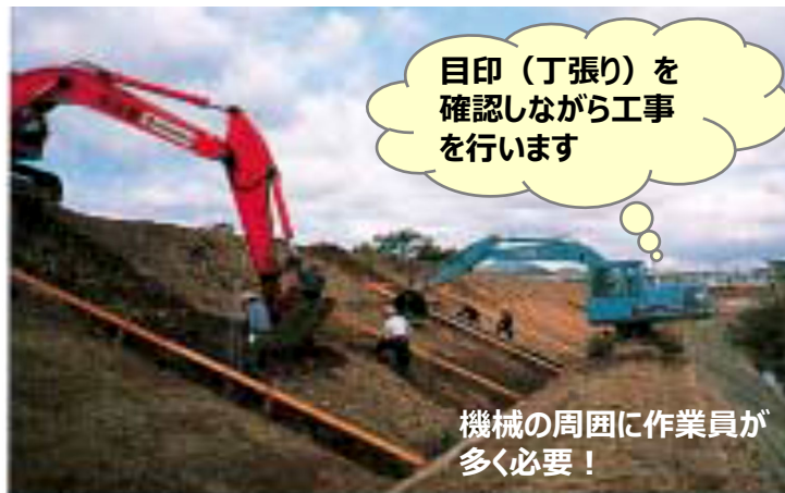
▲目印（丁張り）を確認しながらの施工
