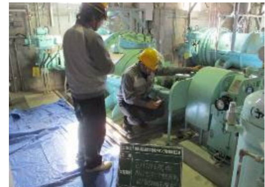
主ポンプ 振動測定の例
