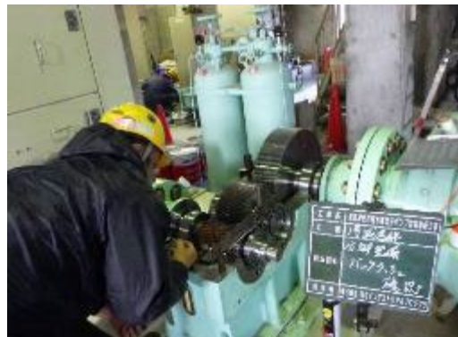
減速装置点検の例
