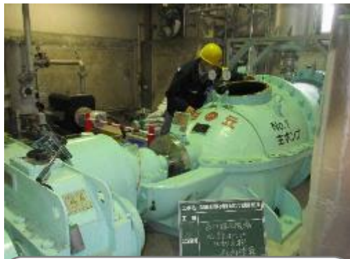
主ポンプ点検の例
