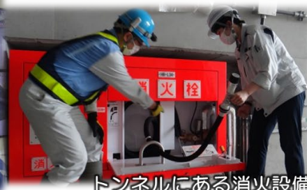
トンネルにある消火設備
