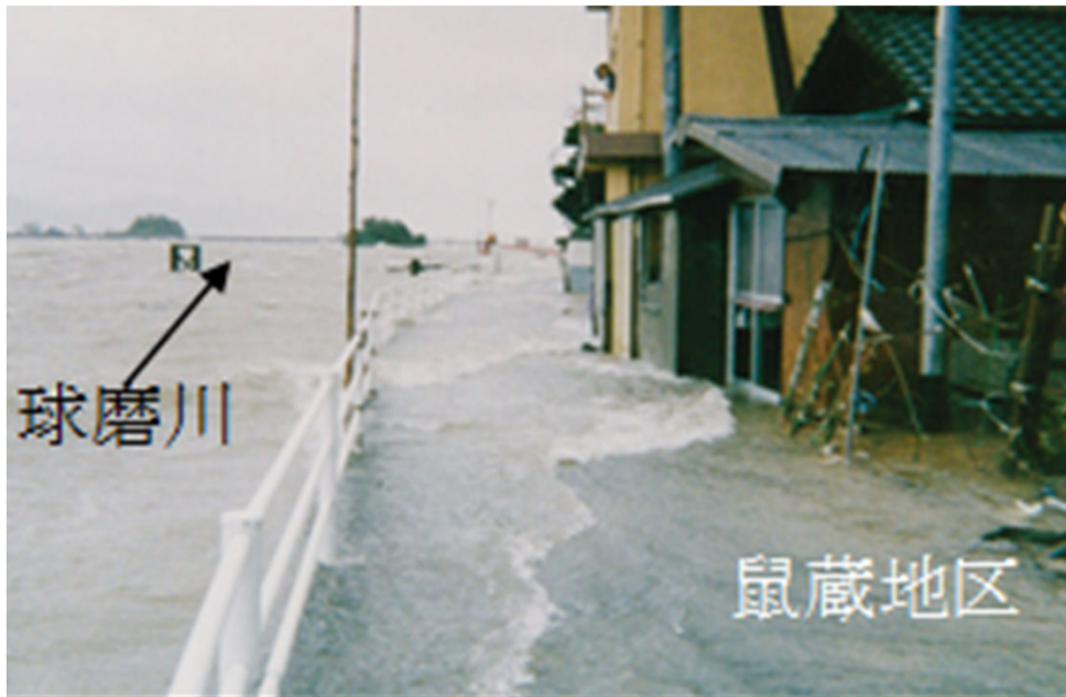
そぞう 鼠蔵地区浸水状況 (八代市鼠蔵町)
