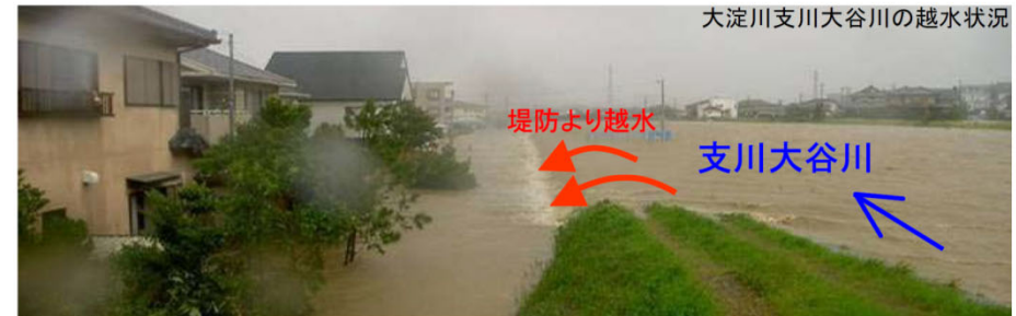
大淀川支川大谷川の越水状況
