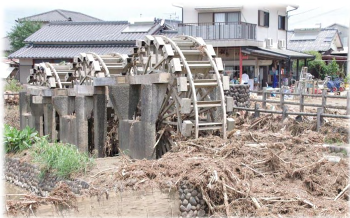
平成29年7月 九州北部豪雨で被災した国史跡 三連水車(福岡県朝倉市)
