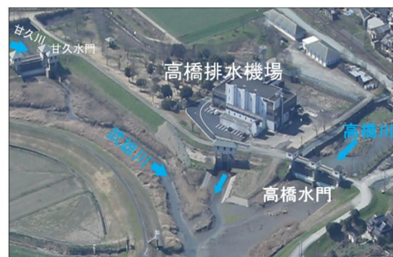
高橋排水機場
