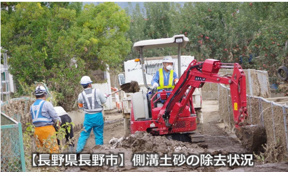
【長野県長野市】側溝土砂の除去状況
