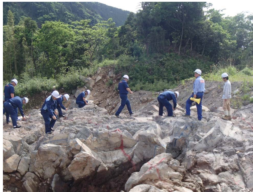
基礎岩盤の視察の様子
