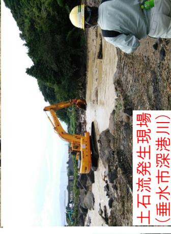
遠隔操縦による復旧作業例
