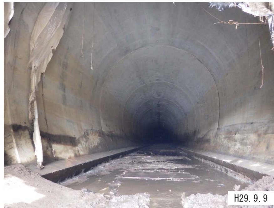
仮排水路トンネル吐口（下流側）の堆積土砂撤去後状況
