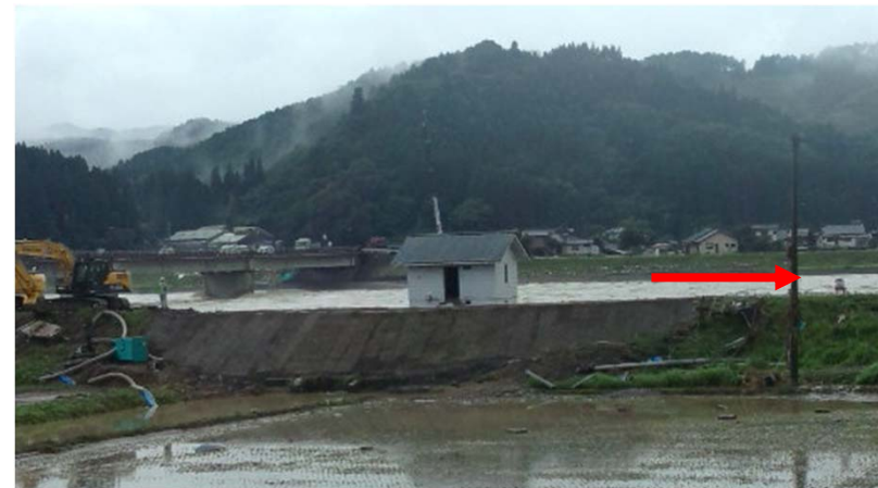
2020.07.06 9時00分頃 仮堤防概成
