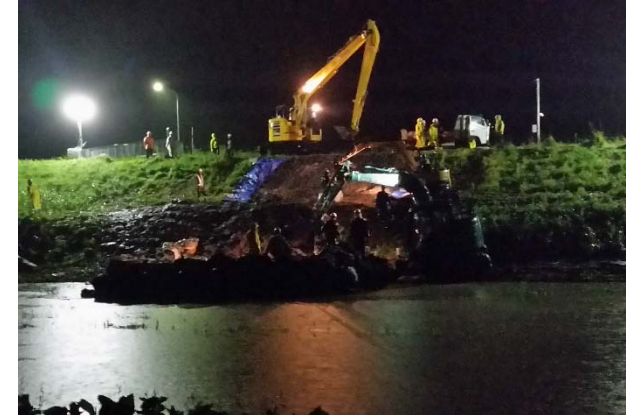
2020. 07. 07 20時00分頃 応急対策夜間作業中
