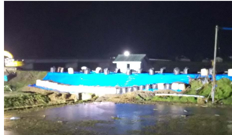
2020.07.06 24時00分頃 緊急復旧完了
