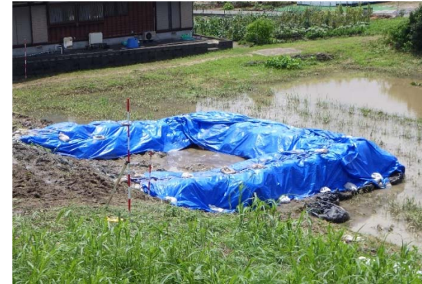
2020. 07. 08 14時20分頃 (07. 07 21:00応急対策工事完了)
