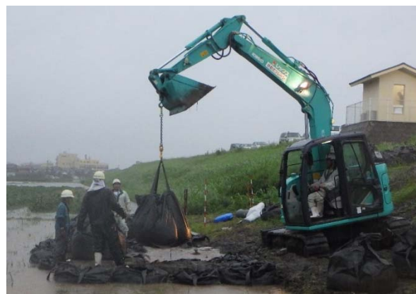
2020. 07. 07 18時00分頃 応急対策作業中
