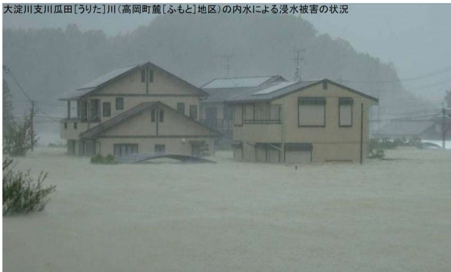
大淀川支川瓜田[うりた]川(高岡町麓[ふもと]地区)の内水による浸水被害の状況
