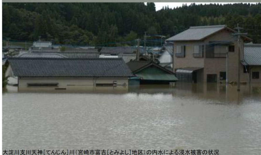
大淀川支川天神[てんじん]川(宮崎市富吉[とみよし]地区)の内水による浸水被害の状況
