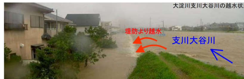
大淀川支川大谷川の越水状況
