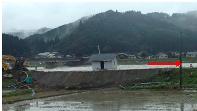
2020.07.06 9時00分頃 仮堤防概成
