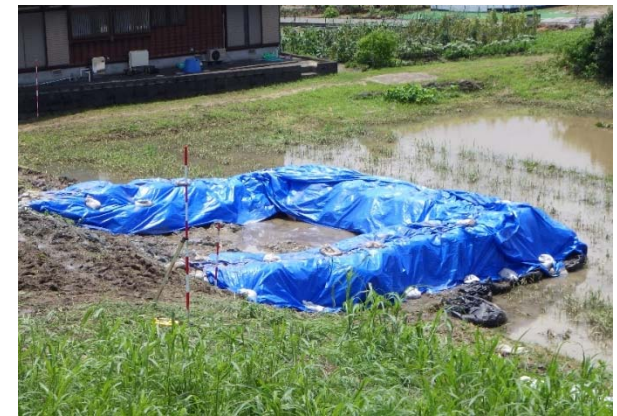
2020. 07. 08 14時20分頃 (07. 07 21:00応急対策工事完了)
