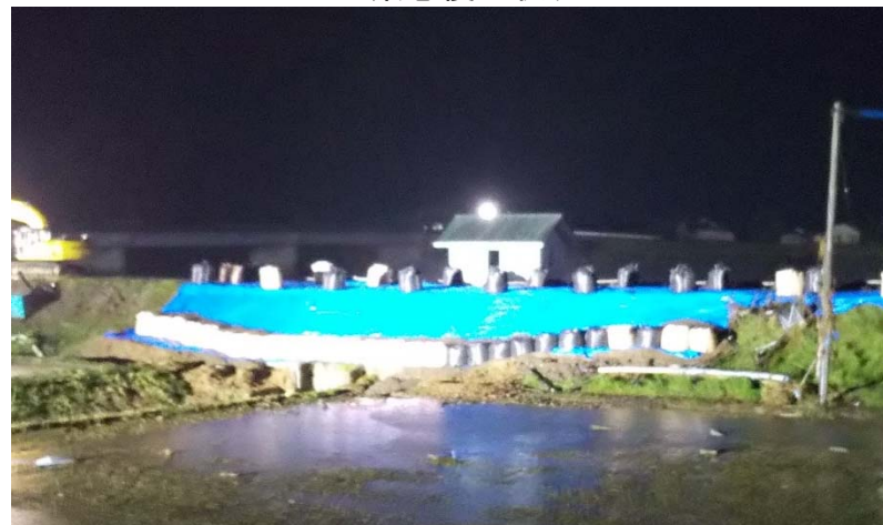
2020.07.06 24時00分頃 緊急復旧完了
