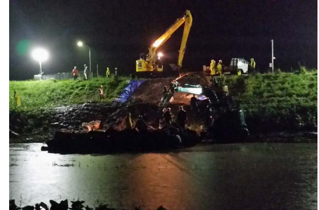
2020. 07. 07 20時00分頃 応急対策夜間作業中
