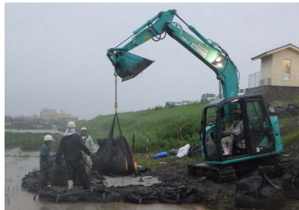
2020. 07. 07 18時00分頃 応急対策作業中
