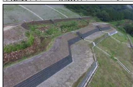
土留盛土工(山側ポケット)、 谷側風化防止工(鋼製土留)
