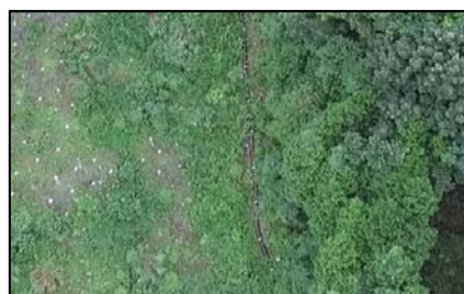
熊本側ガリ— 高強度ネット工+鉄筋挿入工、ロープ伏工
