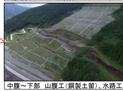
大分側ガリ— 高強度ネット工+鉄筋挿入工、ロープ伏工
