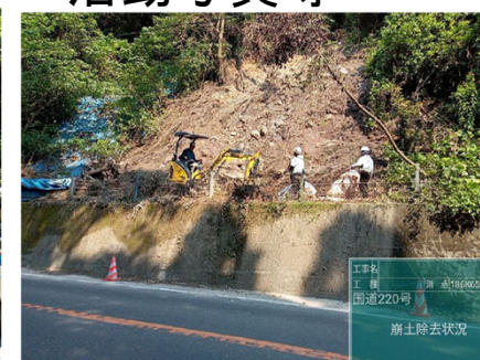
崩土撤去作業
