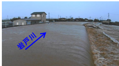
岩戸川の氾濫状況
