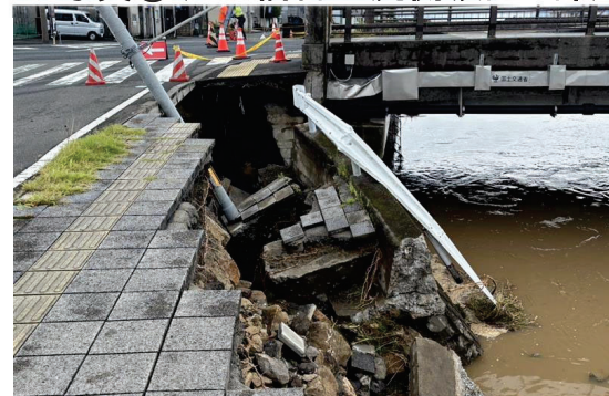
◆写真①(A1橋台上流側吸出し部)
