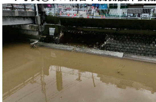
◆写真②(A1橋台下流側護岸損傷)
