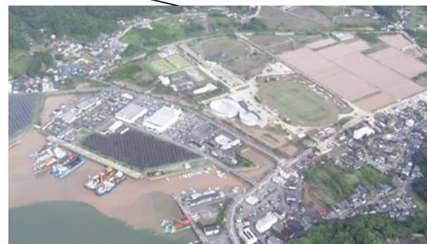
上天草市松島町 合津川 浸水状況
