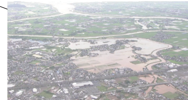
宇土市 宇土駅周辺 浸水状況
