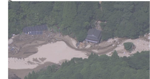
上天草市松島町今泉 土砂崩れ
