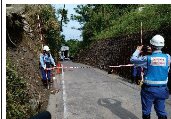
現地被災状況調査 (熊本県水川町)
