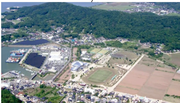
上天草市松島町 合津川 浸水状況
