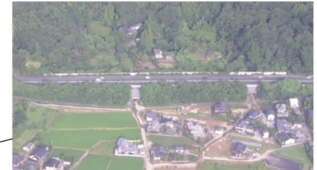
宇城市小川町 土砂流入
