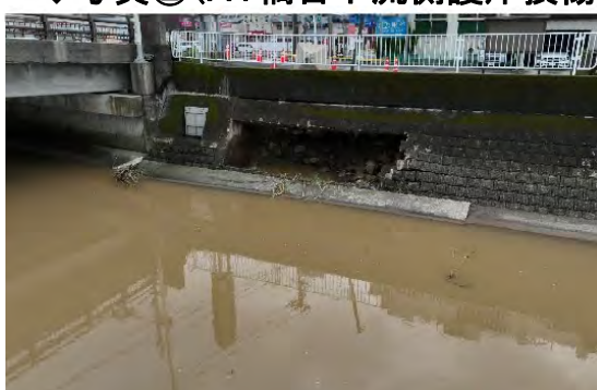
◆写真②(A1橋台下流側護岸損傷)
