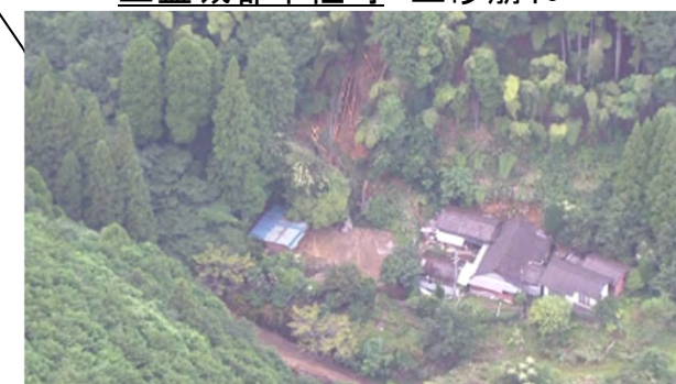
美里町 一の谷川 土砂崩れ
