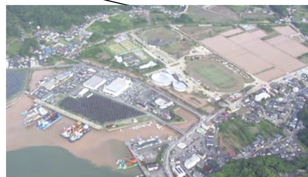
上天草市松島町 合津川 浸水状況
