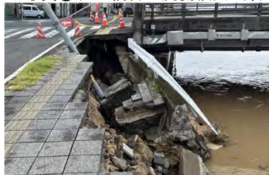
◆写真①(A1橋台上流側吸出し部)
