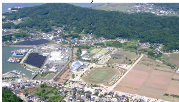
上天草市松島町 合津川 浸水状況
