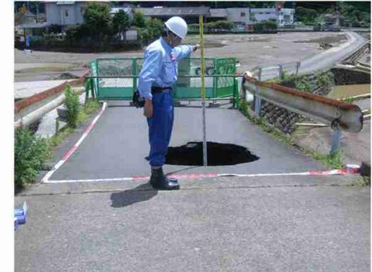
○橋台背面の空洞状況(1.4m×1.5m)
