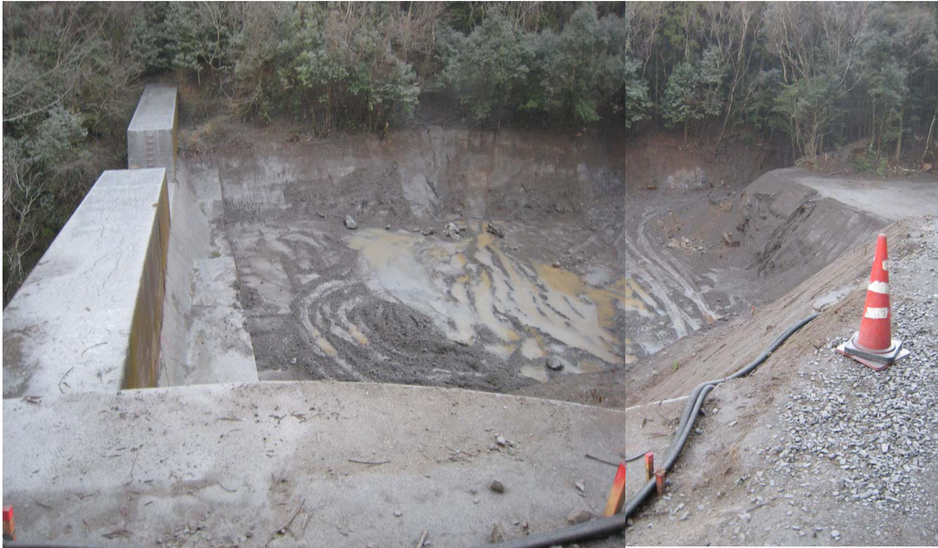
祓川【高原町蒲牟田地先】の緊急的除石工事の完了状況
