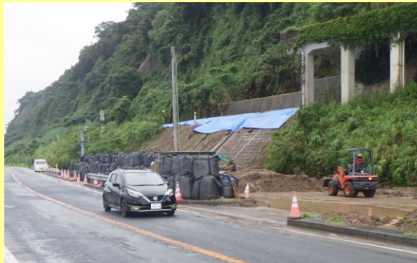
応急復旧状況
