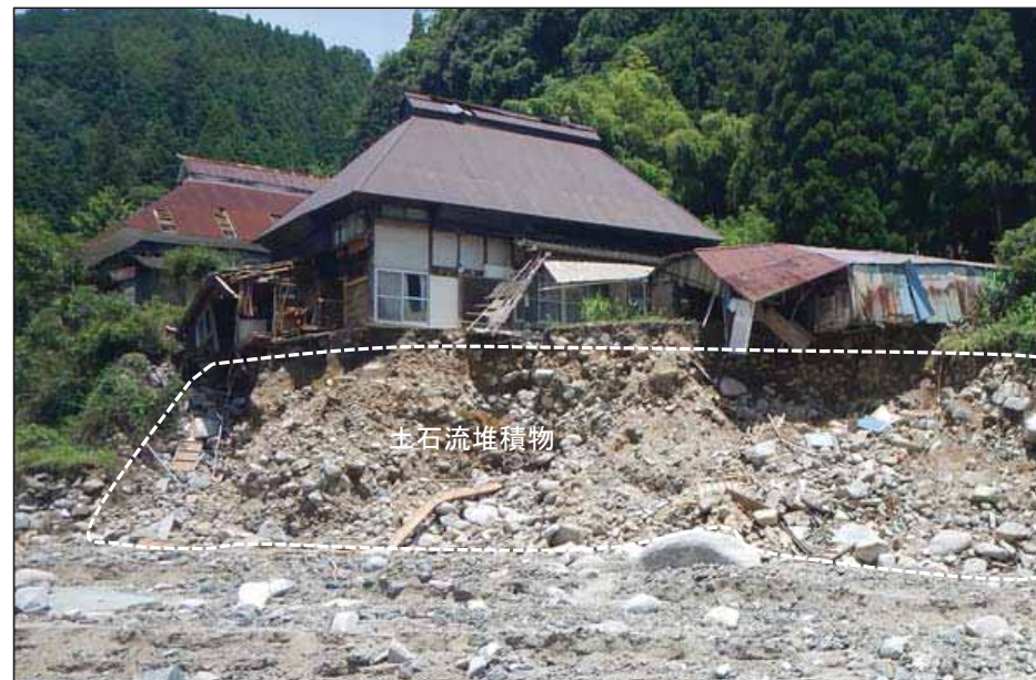
乙石川2k500付近の家屋下部侵食面に見る過去の土石流堆積物
