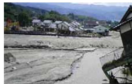
土砂等を除去し河積を確保
