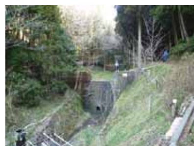
馬の谷砂防堰堤 S48竣工 高さ5m
