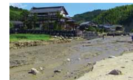
土砂等を除去し河積を確保
