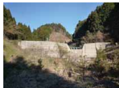
荒廃砂防堰堤 H3竣工 高さ10m
