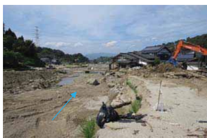
⑤着工前(3k700付近)
