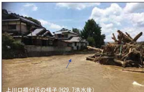
上川口橋付近の様子(H29.7洪水後)
