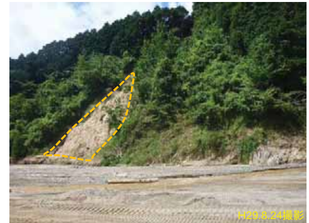
③ 表層崩壊の例 ・ 勾配が30度以上の斜面が崩壊 ・ 崩壊深は1~2mと薄い
