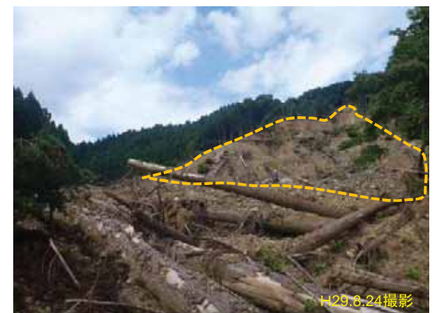
⑥ 地すべり移動体範囲内での大規模崩壊 ・ 地すべりブロックの一部が崩壊
