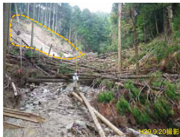
⑤ 風化層が厚い緩斜面の崩壊 ・ 勾配が30度以下の斜面が深く崩壊
