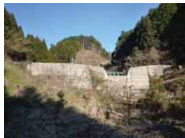
荒廃砂防堰堤 H3竣工 高さ10m
