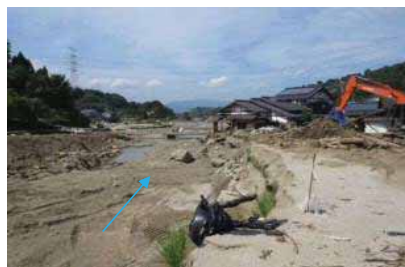
⑤着工前(3k700付近)
