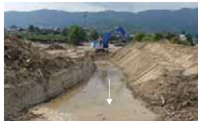
土砂により埋塞した河道の復旧工事
