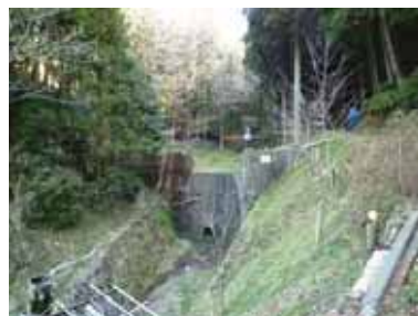
馬の谷砂防堰堤 S48竣工 高さ5m
