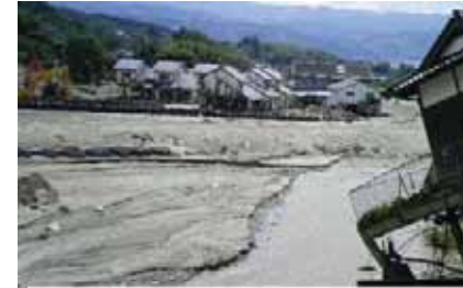
土砂等を除去し河積を確保
