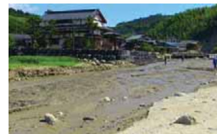
土砂等を除去し河積を確保
