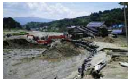
住家前に大型土のうを据え付けて、 河岸侵食を防止
