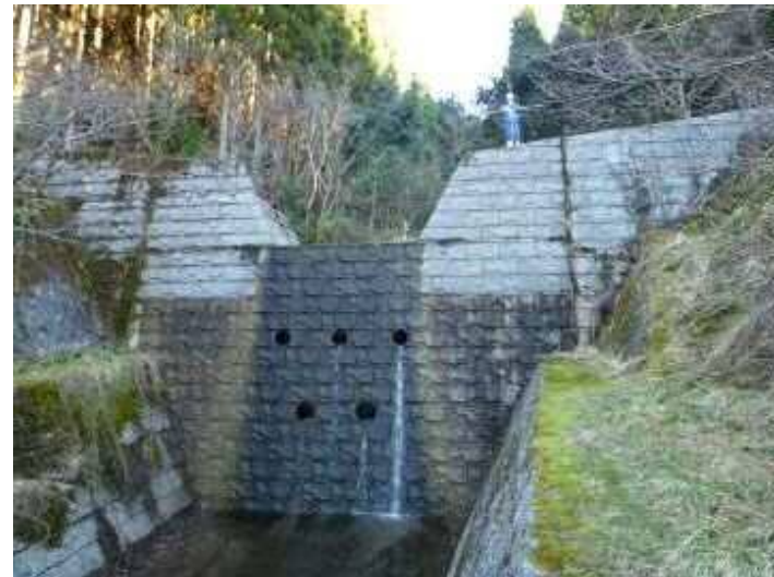
汐井谷砂防堰堤(福岡県朝倉県土整備事務所)
