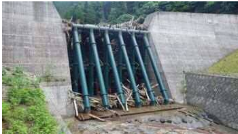
田良川砂防堰堤(大分県中津土木事務所)※1
