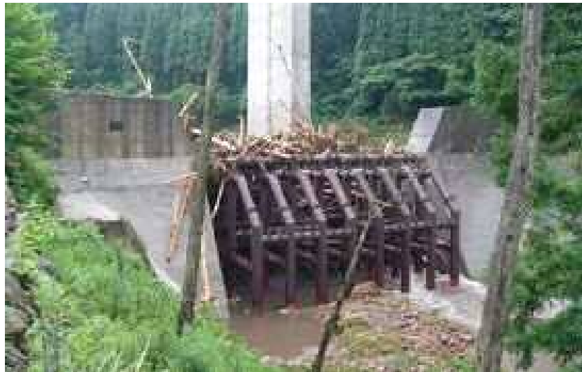
北里川砂防堰堤(熊本県阿蘇地域振興局)※1
