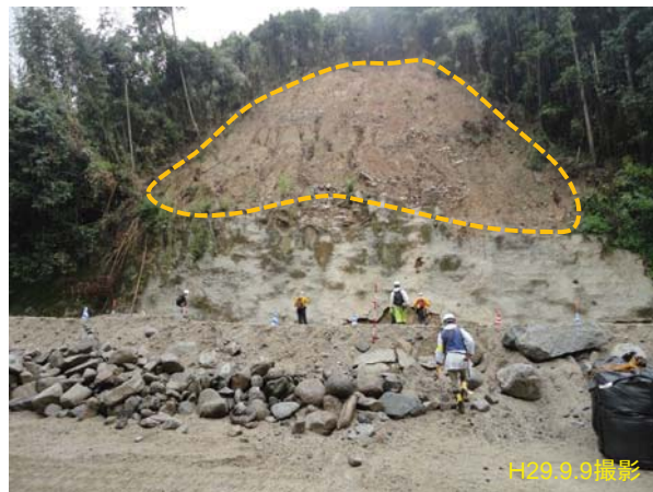
④ 遷急線上部の尾根付近の崩壊 ・ 尾根付近の緩勾配斜面で崩壊
