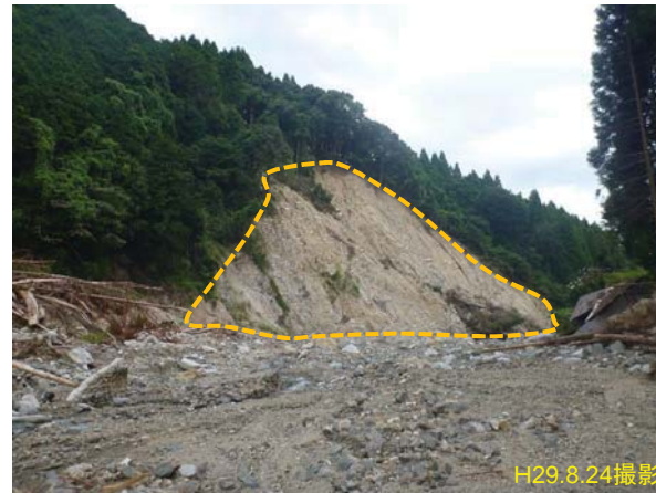
② 溪岸崩壊の例 ・ 溪岸脚部が流水で侵食 ・ 上部斜面が崩壊
