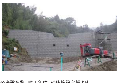
大山川2号砂防堰堤 H21竣工 高さ10.5m
