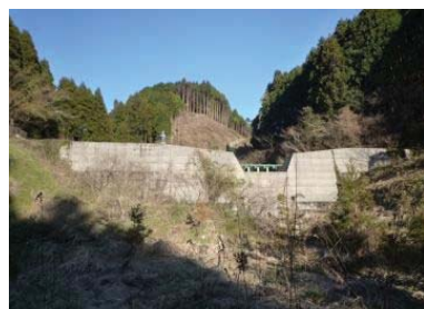
荒廃砂防堰堤 H3竣工 高さ10m
