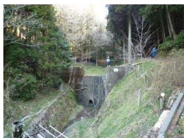
馬の谷砂防堰堤 S48竣工 高さ5m
