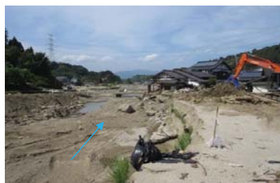
⑤着工前(3k700付近)
