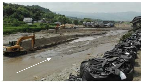
大型土のうを据え付けて河道を掘削
