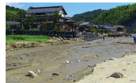
土砂等を除去し河積を確保
