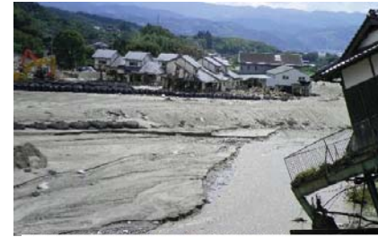
土砂等を除去し河積を確保
