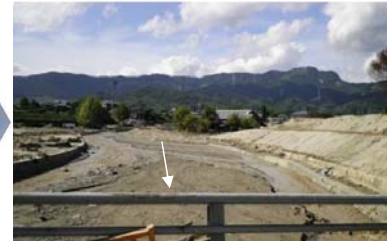
土砂等を除去した河道
