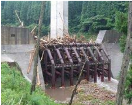
北里川砂防堰堤（熊本県阿蘇地域振興局）
