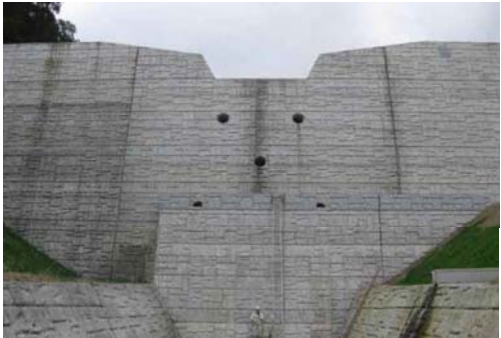
大山川砂防堰堤（福岡県朝倉県土整備事務所）
