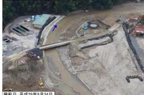
図 6.3.33 橋梁の被災状況（赤谷川：川口橋）
