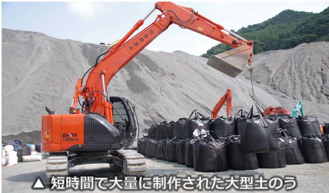
▲ 3機の大型土のう簡易制作機で作業開始
