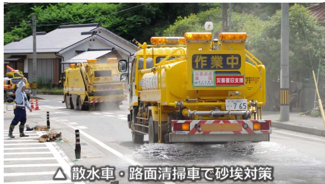
△ 散水車・路面清掃車で砂埃対策
