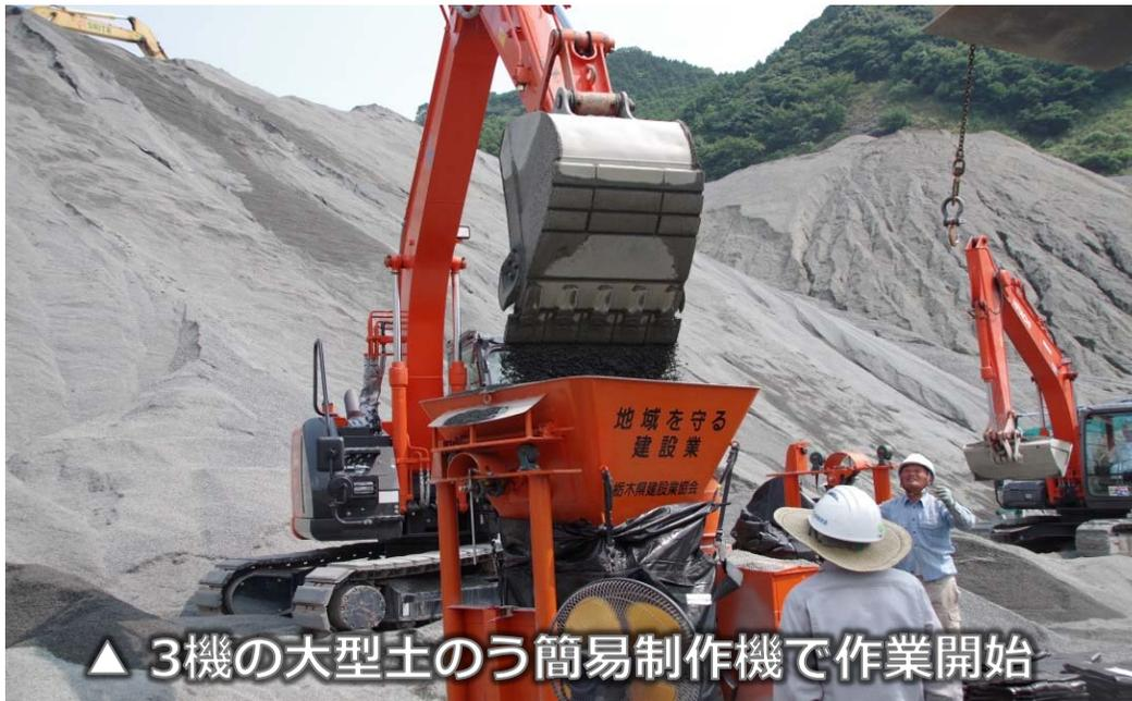
▲ 3機の大型土のう簡易制作機で作業開始
