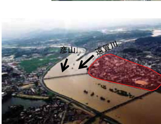
■直方地区の出水状況 (H15年7月)
