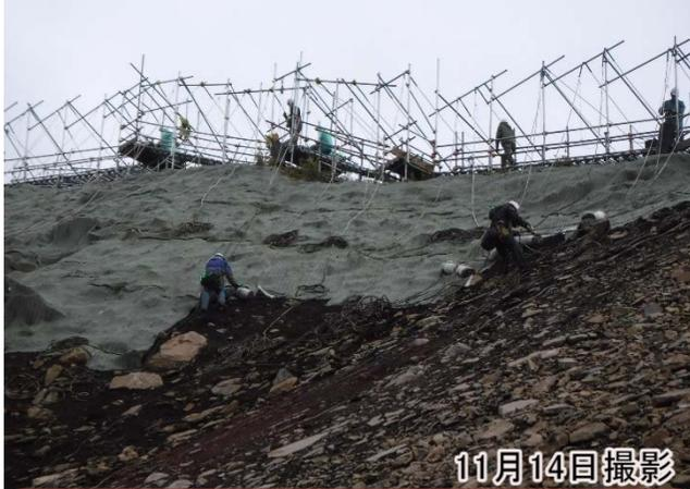
恒久対策施工に向け、アンカー引抜試験を実施中
