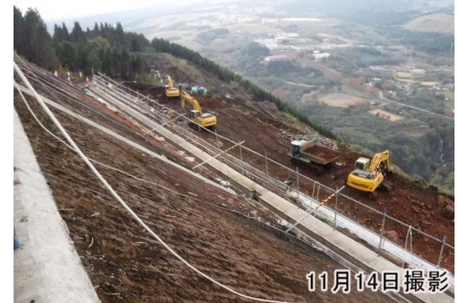
崩壊斜面下部に残る崩壊土砂撤去後、地下水、湧水に対する排水処理対策を進めています。
