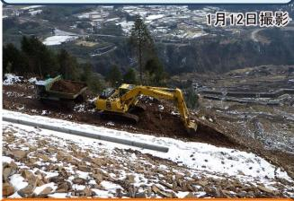
構造物構築のための盛土作業と並行して、斜面からの排水施設を整備しています。
